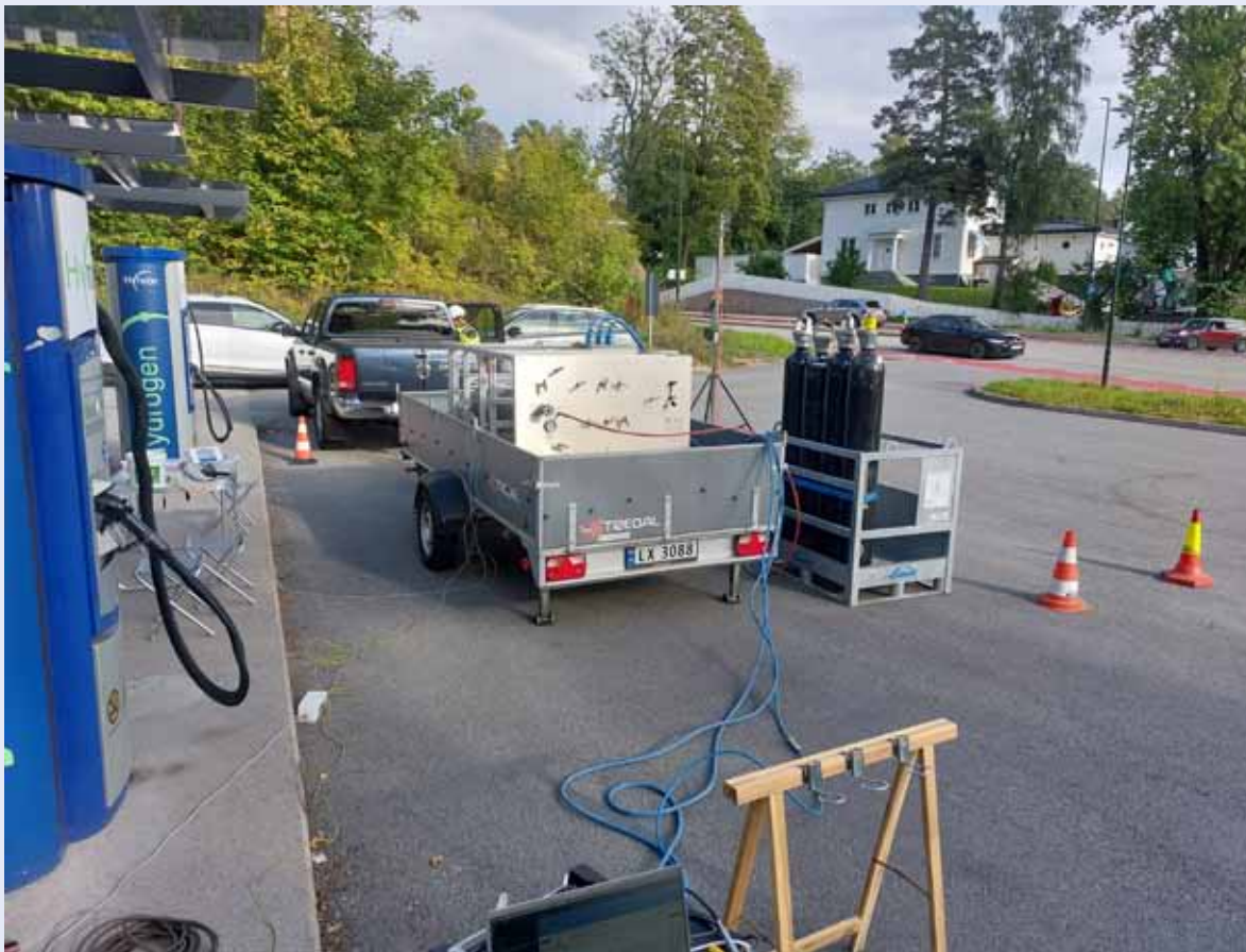
Justervesenets spesialbygde kalibreringsrigg i aksjon på Høvik. Ved hjelp av riggen kan det etableres referanseverdier for kontroll av fyllestasjoner for hydrogen.
